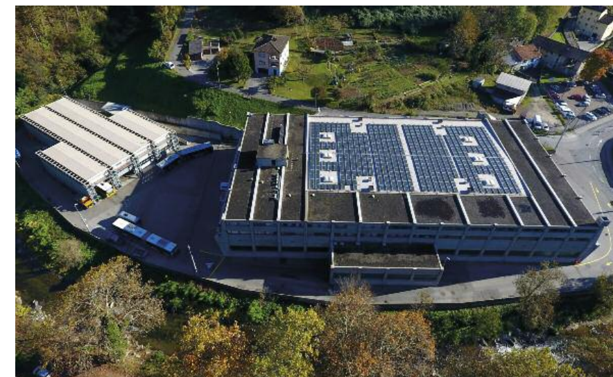
Stabile TPL con pannelli fotovoltaici.
